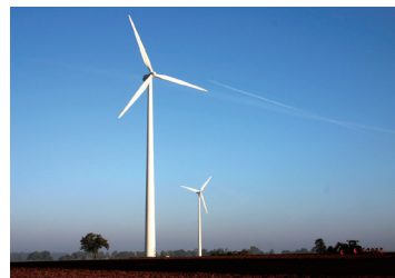
風力発電プラント
